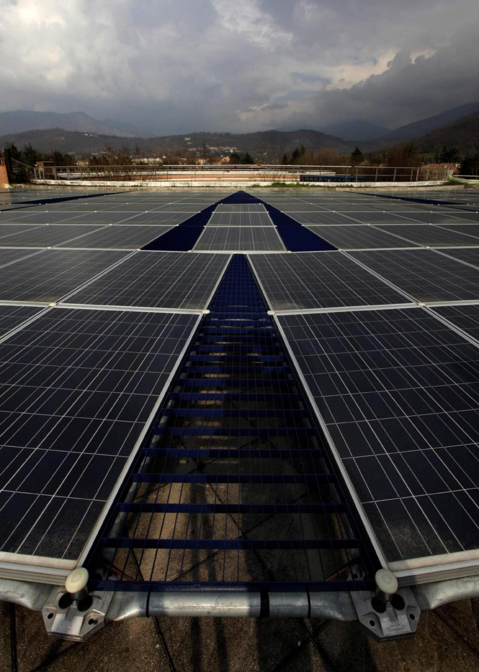
L'impianto da 100 KW rappresentato in foto, è stato montato in completo appoggio, senza quindi la necessità di forare il tetto. Il telaio Omniablok, diviso sulle due falde di ogni tetto, è collegato da una serie di piastre (rappresentate in rosso in alto a destra) che valicano il punto di colmo della copertura, passando al di sotto della lamiera di chiusura.
